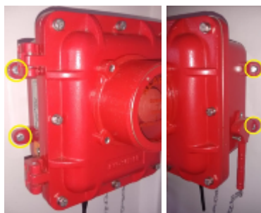
Figura 1 - Localização dos pontos de fixação do lado esquerdo e direito da LRAEX.
